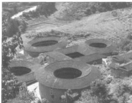
图5 福建土楼 Fig.5 Fujian earth building
